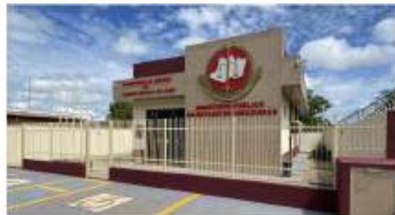
Figura - Construção de Promotória de Justiça de Boca do Acre – MPAM.
