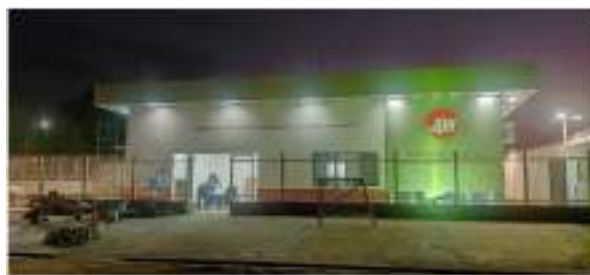
Figura - Construção de Promotoria de Justiça de Presidente Figueiredo – MPAM.
