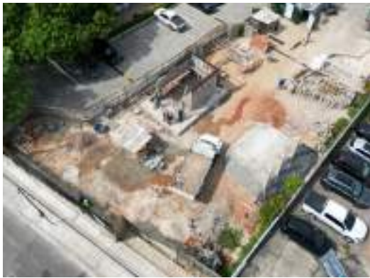
Figura - Obra da guarita do prédio sede do Ministério Público do Estado do Amazonas – MPAM
