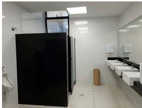
Reforma dos banheiros – Sede do MP/AM.
