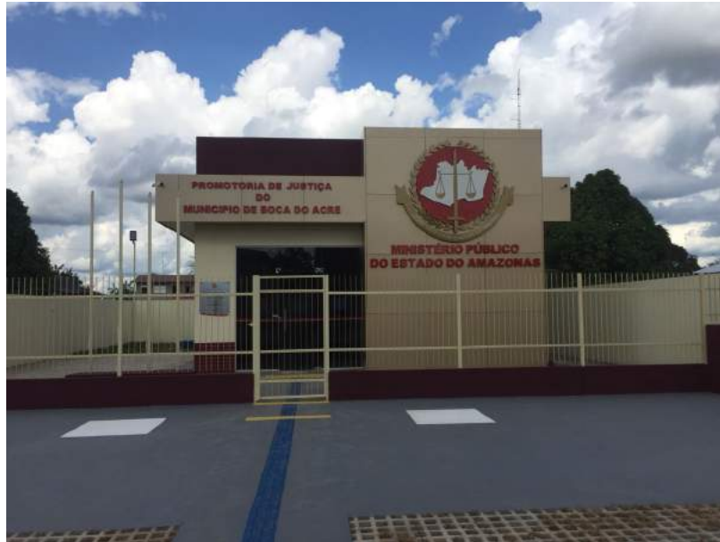
Figura 2 - Edificação – Promotoria de Justiça de Boca do Acre
