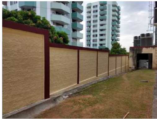
Figura 1 - Reconstrução do muro – Sede do MP/AM.
