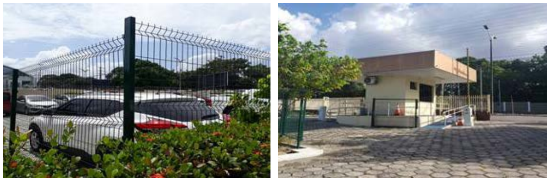
Readequação do estacionamento – Sede do MP/AM
